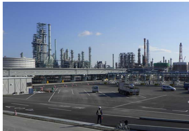
仙台製油所：建設が進む陸上出荷設備
